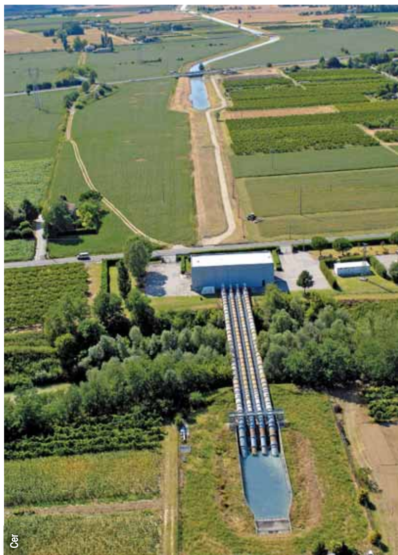
Impianto idrovoro del Cer sulla sponda sinistra del Savio, a Mensa di Ravenna
